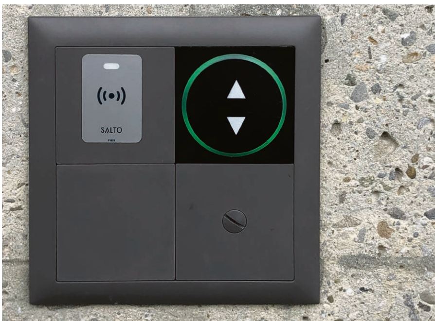
« Pour entrer à la tour des Rammes, passez la main devant le cercle vert ! © JCP »
