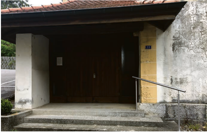
Merci à la municipalité de Missy d'avoir posé cette main-courante qui facilite l'accès à l'église. © JCP
