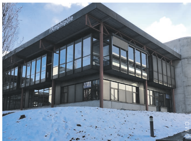
L'Amphipôle accueille les nouveaux locaux de l'aumônerie de l'Université de Lausanne.
